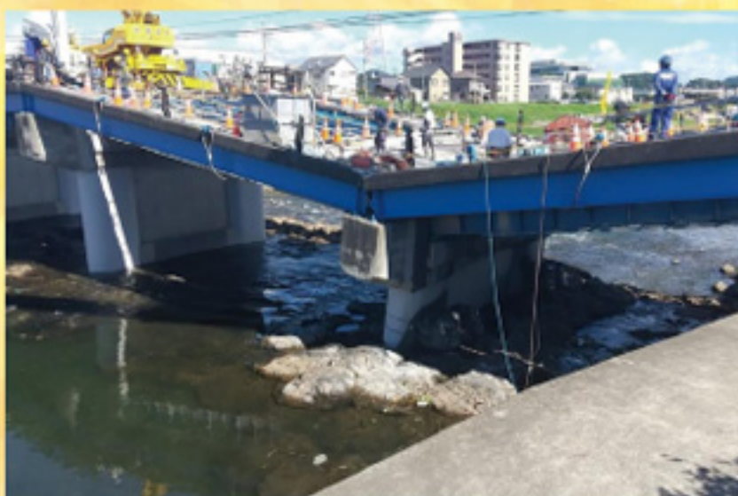
黄瀬川大橋は、令和3年8月31日(火)仮設橋にて通行可能に！(歩行者・総重量7.5t未満の車両のみ)
